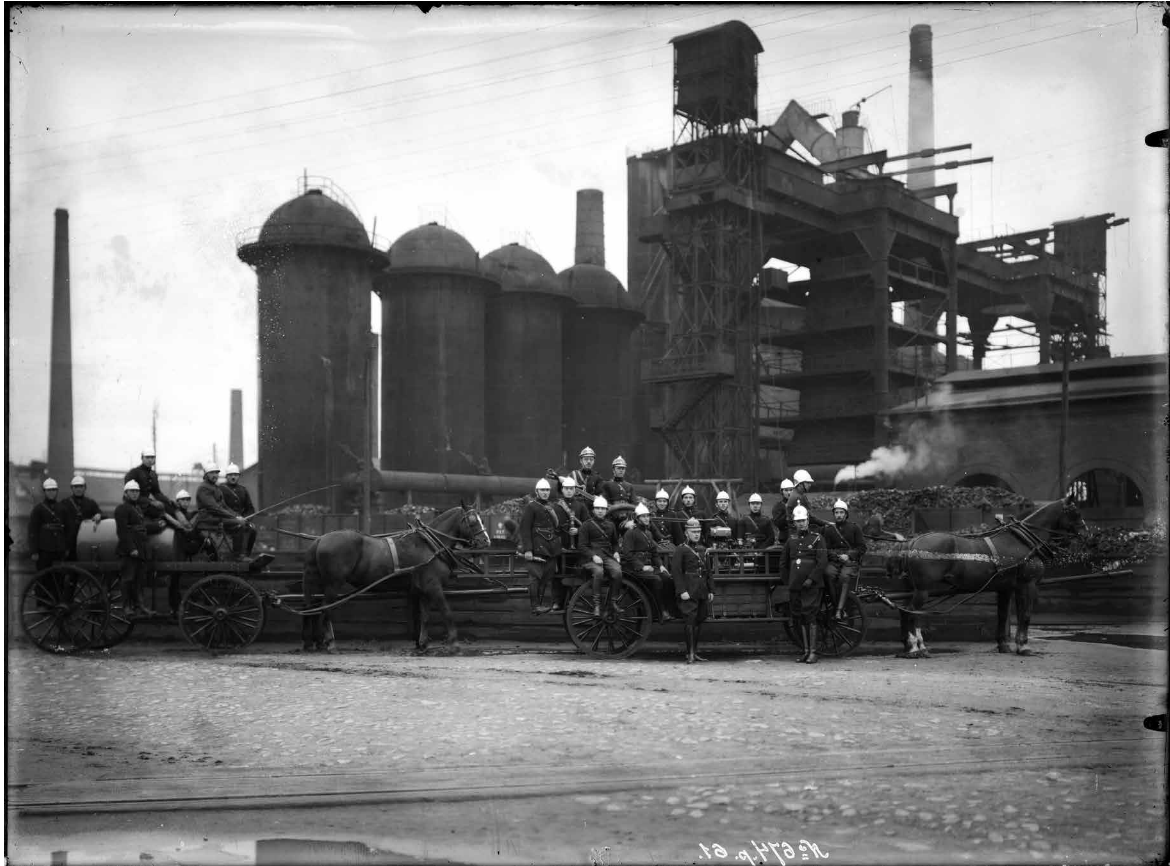
113. Straż pożarna Zakładów Ostrowieckich, przed 1933. / Fire brigade of the Ostrowiec Plant, before 1933. →
